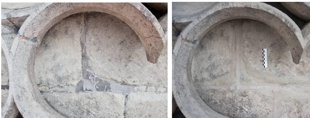
Fig. 3: Colonia, Catedral, Ventana S 3, área de la pared en la tracería, antes (izquierda) y después (derecha) de la restauración © Dombauhütte Köln / foto: M. Unkelbach
