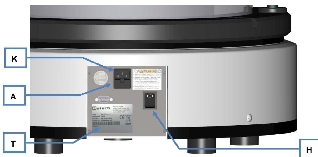
Fig. 20: Sustitución de los fusibles
